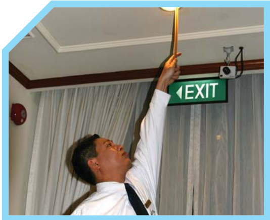
KIỂM TRA ĐÈN BÁO KHẨN CẤP
