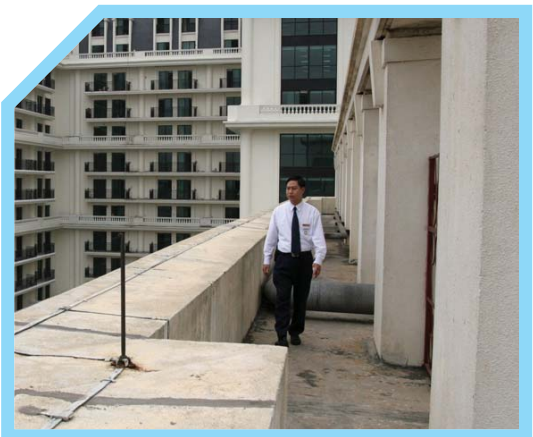
KIỂM TRA MÁI NHÀ
