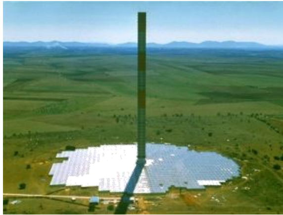
Hình 3.3 Tháp năng lượng Mặt trời Hệ thống sử dụng gương parabol tròn xoay định vị theo phương mặt trời để tập trung NLMT vào một bộ thu đặt ở tiêu điểm của gương, nhiệt độ có thể đạt trên 1500oC.
